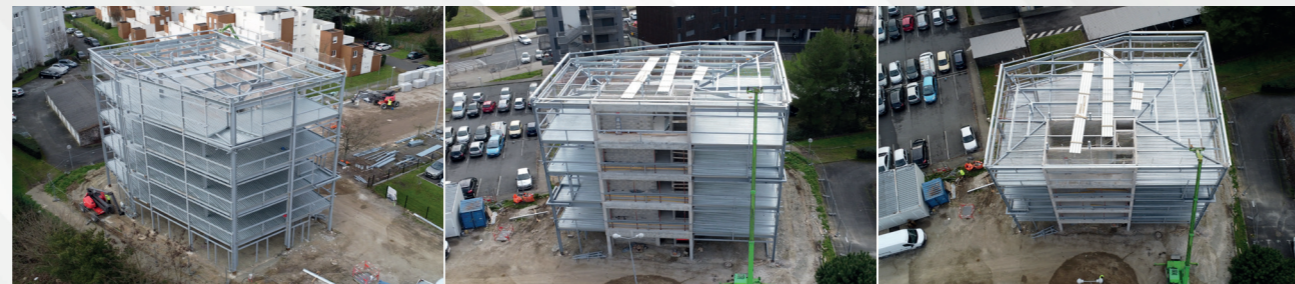
Construction en cours
